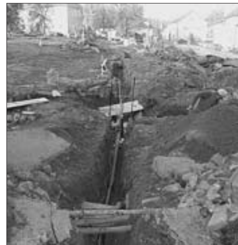
Bylo odkryto vodovodní vedení v celé ploše náměstí, došlo k jeho posouzení
