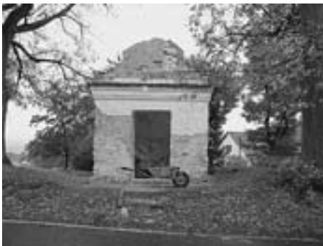
Opravena byla i morová kaple v Prčici
