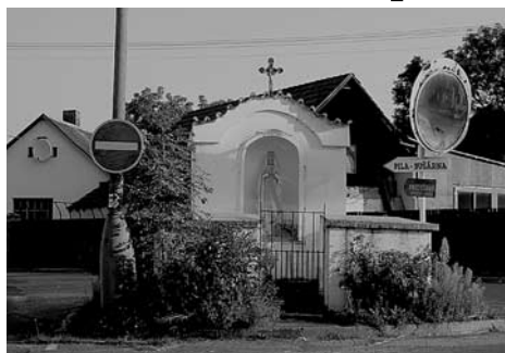
Kaplička v Prčici před opravou
