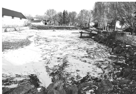
Oprava rybníku v Divišovicích
