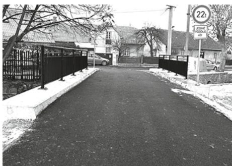
Rekonstrukce mostku v ulici Dlážďená a hotové dílo po předání do provozu
