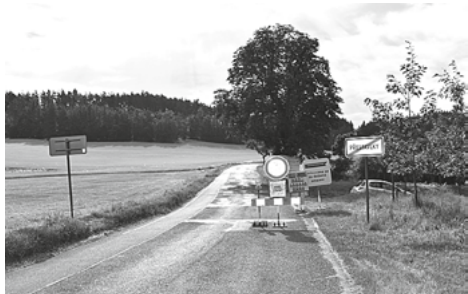
Začínají se opravovat silnice
