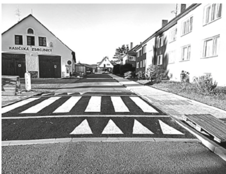
Výstavba chodníku a bezpečného přechodu pro chodce v ulici Družstevní v Sedlci
