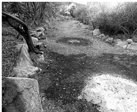
Byly provedeny terénní úpravy některých cest
