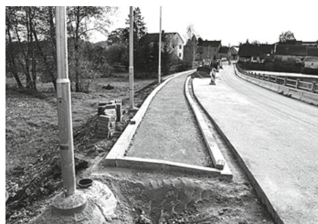
Stav prací na chodníku začátkem listopadu
