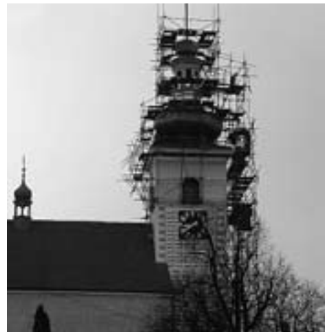
Oprava věže kostela sv. Vavřince v roce 2006
