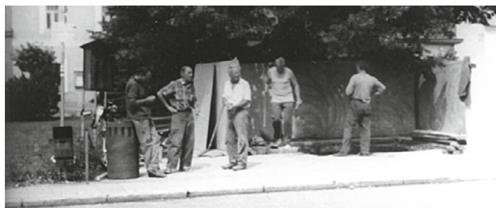
Stavba kašny na náměstí v Sedlci a její slavnostní uvedení do provozu
