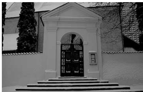
Stav brány a zdi po opravě
