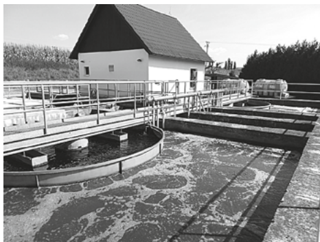
Městská čistírna odpadních vod
