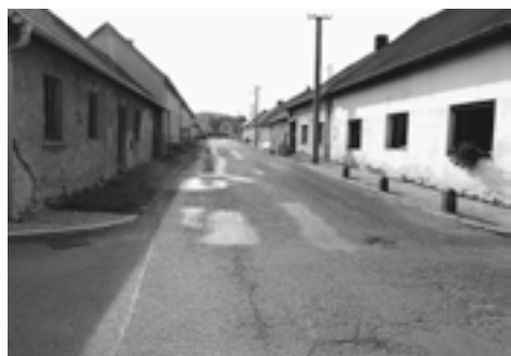
Asfaltový povrch v Nechvalické ulici bude během října vyměněn, foto A. Valsová
