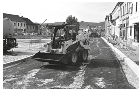
Pokračovalo se na rekonstrukci náměstí
