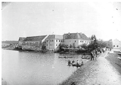
Původně panská zájezdní hospoda před rokem 1902
