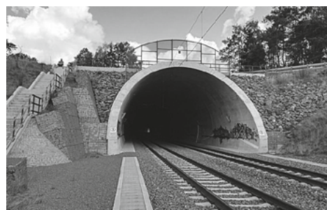
Železniční tunel kousek za vesnicí byl otevřen roku 2015
