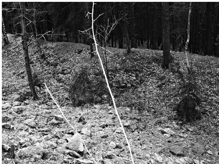
Příkop byl vyzděný
