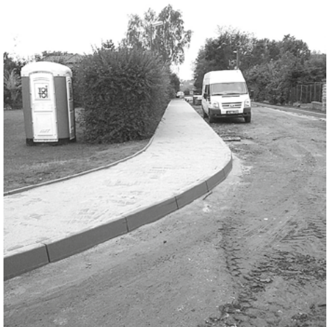
Oprava asfaltového povrchu a výstavba chodníku v Komenského ulici
