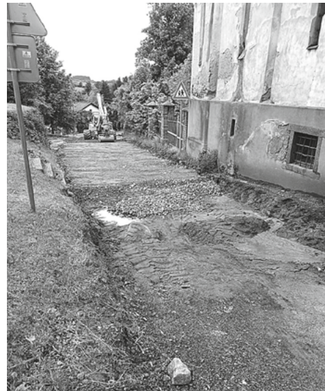
Začaly již práce na silnici v Jetřichovicích u zámku
