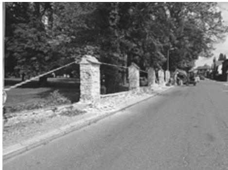
Oprava ohradní zdi zámeckého parku, foto A. Valsová
