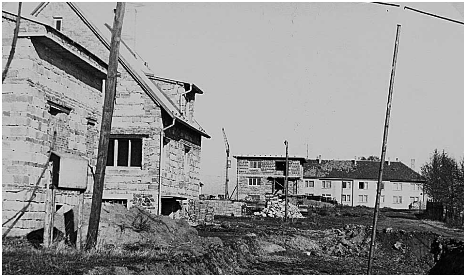
Výstavba nových rodinných domků v Brigádnické ulici v Sedlci v roce 1974
