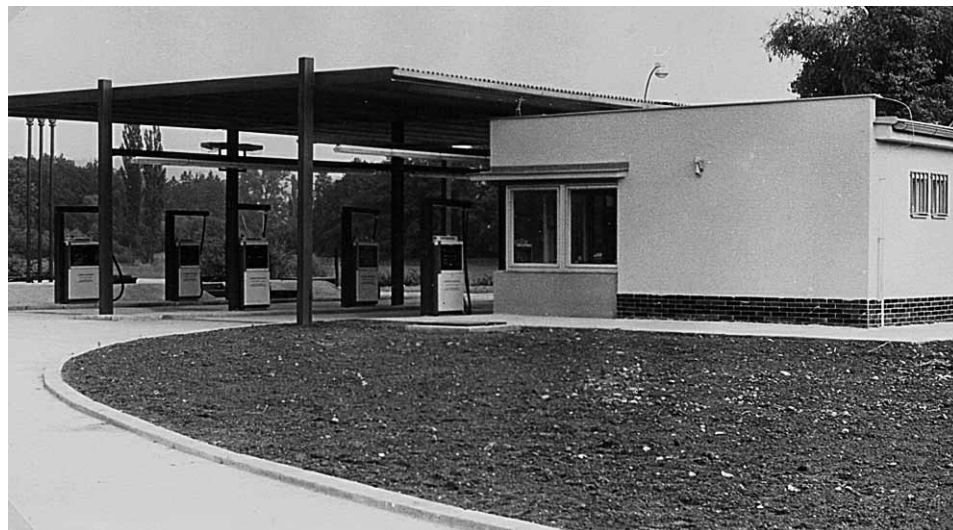
Novostavba čerpací stanice v Sedlci v roce 1984
