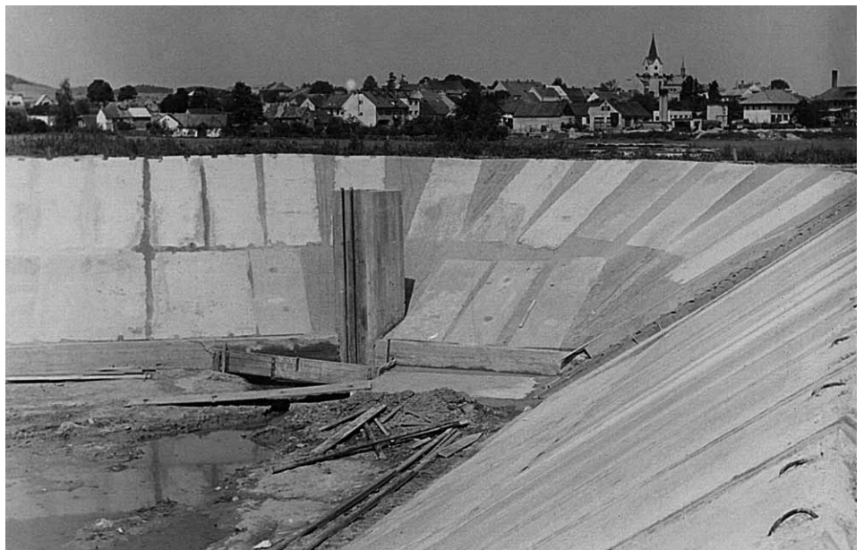
Výstavba „koupaliště“ v Sedlci, rok 1974
