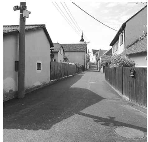
V průběhu dubna se už realizovala oprava ulice Potoční v Prčici
