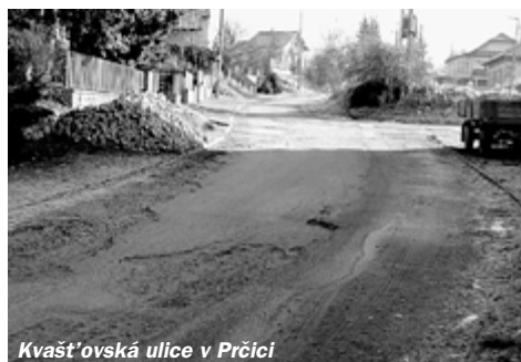
Kvašovská ulice v Prčici
