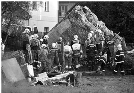
Zřícený most ve Vilémově, foto L. Pavlíček, ČTK
