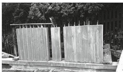
11. 9. – betonuje se nové zábradlí
