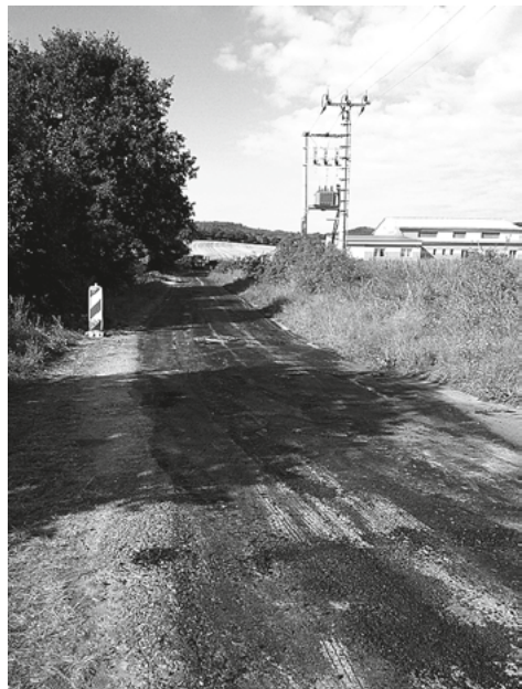
Oprava spojky mezi Sedlcem a Uhřicemi
