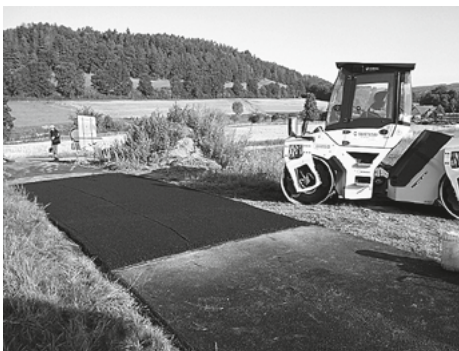
Oprava silnice do Božetína
