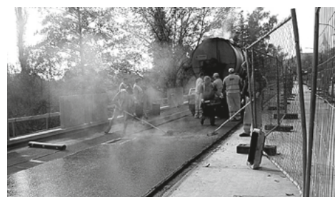
20. 10. – zatímco dělníci vepředu lepí izolační podklad, vzadu se už pokládá spodní asfaltová vrstva
