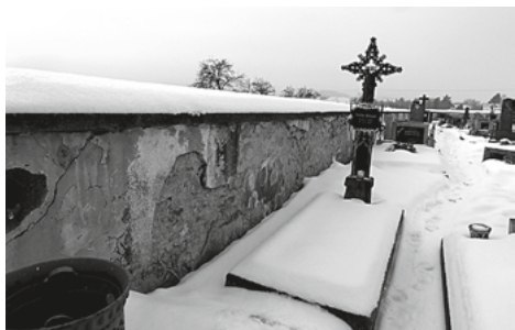
V plánu je oprava hřbitovní zdi v Prčici
