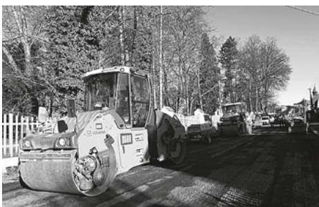
7. 12. – den „D“, bude se asfaltovat
