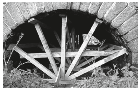
13. 5. – výztuha kleneb mostu
