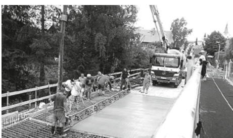
4. 8. – začíná se betonovat
