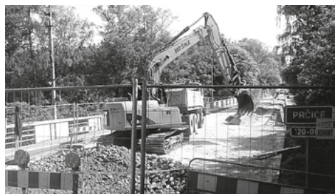
22. 5. – pokračují demoliční práce
