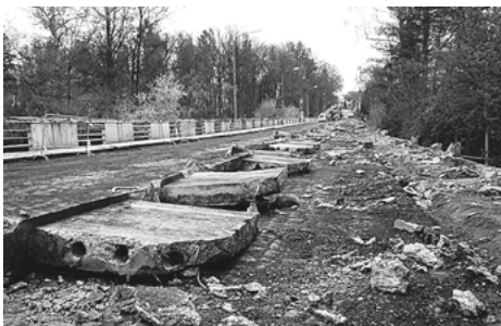
13. 4. – začíná demolice zábradlí
