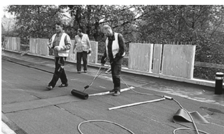
20. 10. – zatímco dělníci vepředu lepí izolační podklad, vzadu se už pokládá spodní asfaltová vrstva
