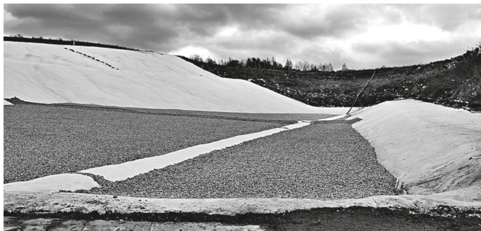
Nová velkokapacitní jáma k ukládání komunálního odpadu na skládce ve Voticích, foto Fr. Vávra
