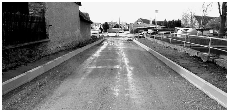
Nové obrubníky v Kvaš'ovské ulici
