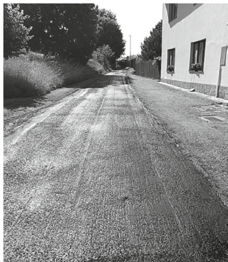
první vrstva tzv. mikrokoberce v Malkovicích
