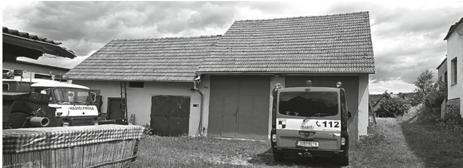
Objekt stávající hasičské zbrojnice je pro potřeby sboru už dlouhodobě nevyhovující
