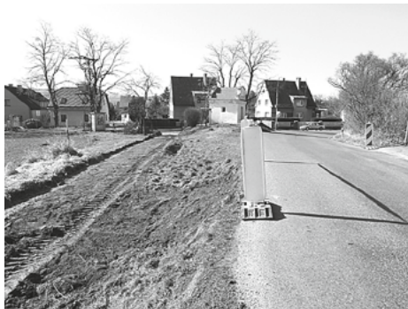
Hned 1. března se začalo s výstavbou chodníku
