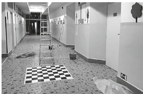
O prázdninách se ve škole opravovalo
