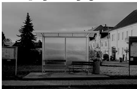
Nový přístřešek pro cestující byl na náměstí v Sedlci instalován v půli listopadu.
