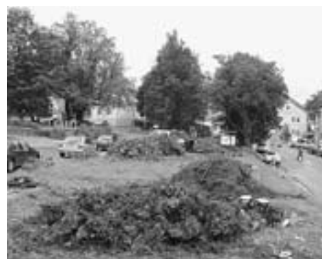
1. září se začalo s kácením stávající zeleně
