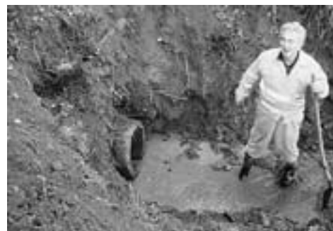
Oprava propustku pod silnicí v Bolechovicích
