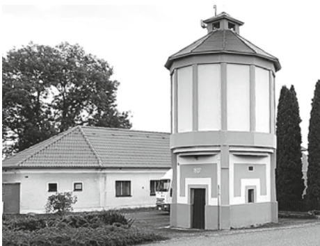
Vodojem z roku 1927
