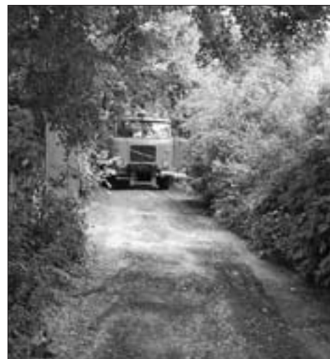
Přípravné práce na opravě cesty v Matějově
