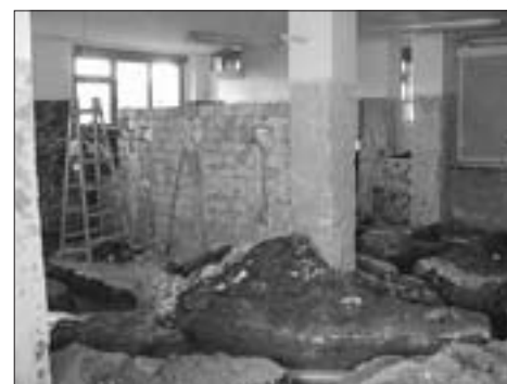
Rozkopaná školní kuchyně
