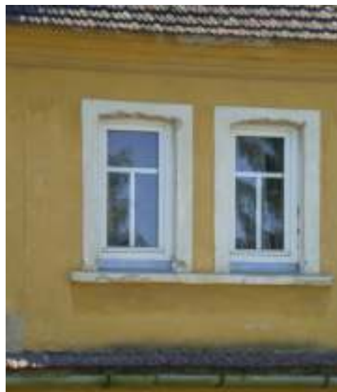
RÁMY NEZAPUŠTĚNÉ DO OSTĚNÍ A ÚZKÉ PŘÍČLE
