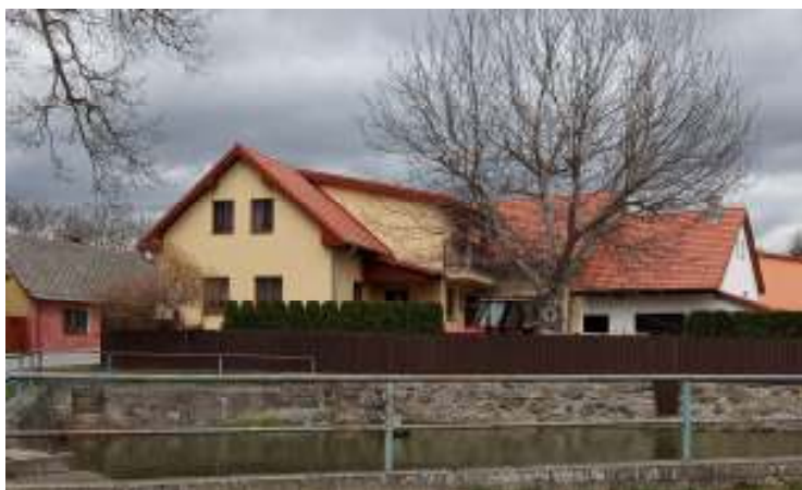
TVAROVĚ NEVHODNÁ PŘÍSTAVBA A NÁSTAVBA, PŘESTOŽE PROPORCE A ROZMÍSTĚNÍ OKEN VE ŠTÍTU JSOU ZDAŘILÉ
