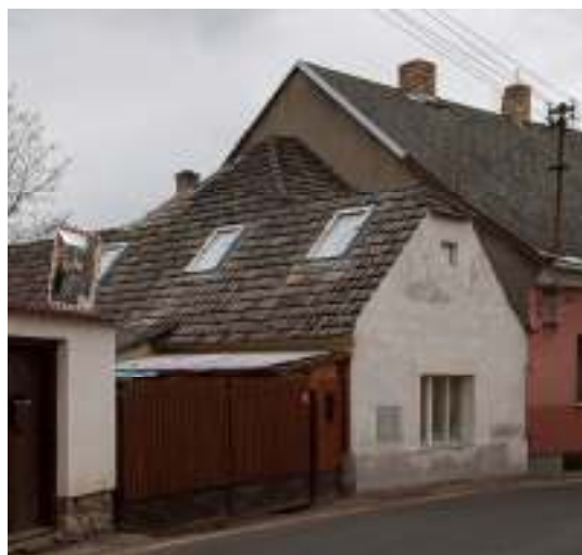
STŘEŠNÍ OKNO PŘÍLIŠ BLÍZKO ŠTÍTU
