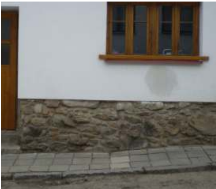
ODHALENÍ A VYSPÁROVÁNÍ KAMENNÉHO ZDIVA
