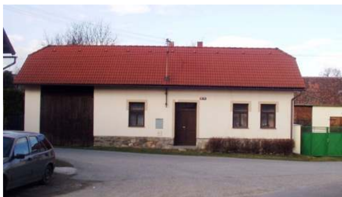
TVAROVĚ A PROPORČNĚ VHODNÁ REKONSTRUKCE DOMU KLASICISTNÍHO PŮVODU S ÚPRAVOU POČ.20.STOLETÍ
