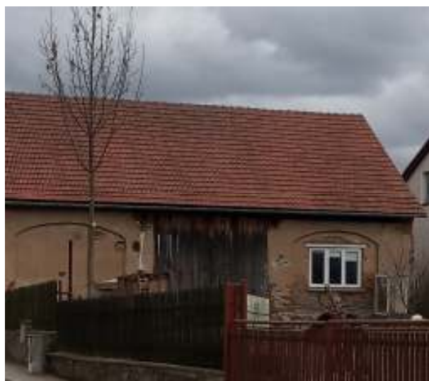
NEVHODNÝ TVAR A ČLENĚNÍ OKNA STODOLY
