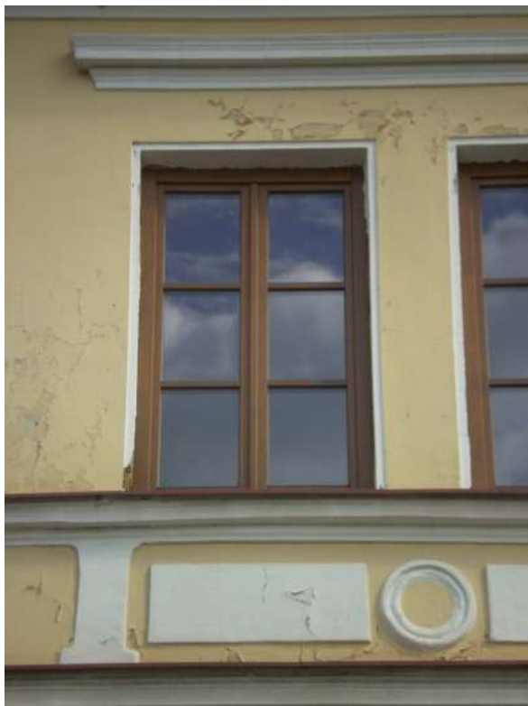
ZDARILÁ VÝMĚNA OKEN
