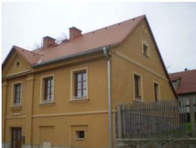
Č.p.110 UL. BRATŘÍ ČECHŮ
