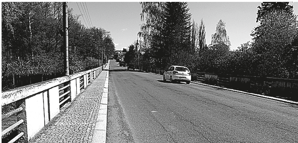
Oprava mostu Karla Burky by měla začít 10. dubna, foto Alice Valsová
