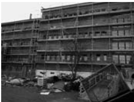
Z nádvoří i budovy školy se stalo staveniště
