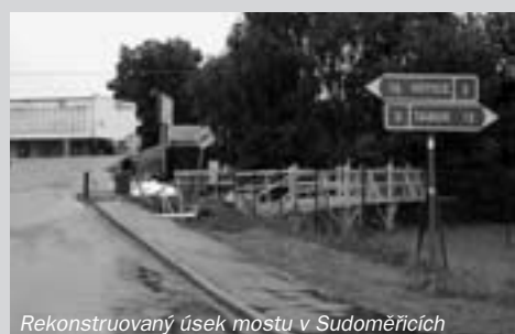
Rekonstruovaný úsek mostu v Sudoměřicích
