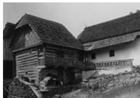
Caltova komora v Sušeticích
