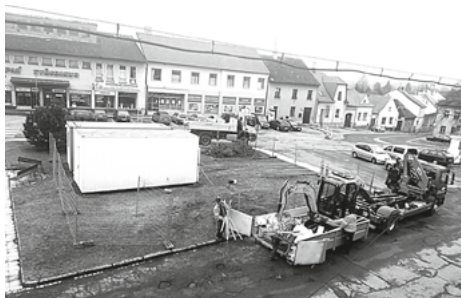
Na konci března stavební firma převzala staveniště
