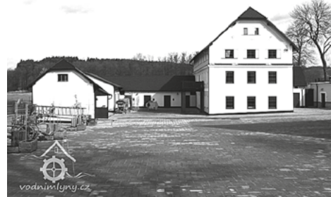
Uprostřed obce Božetice jsou nádherně opravené budovy bývalého Šerhantova mlýna.
