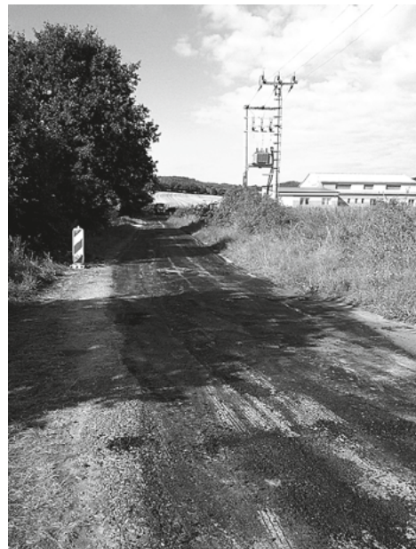
Opravovaná část silnice ze Sedlce do Uhřic
