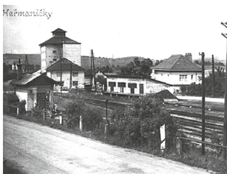
Dráha s budovou skladu hospodářského družstva
