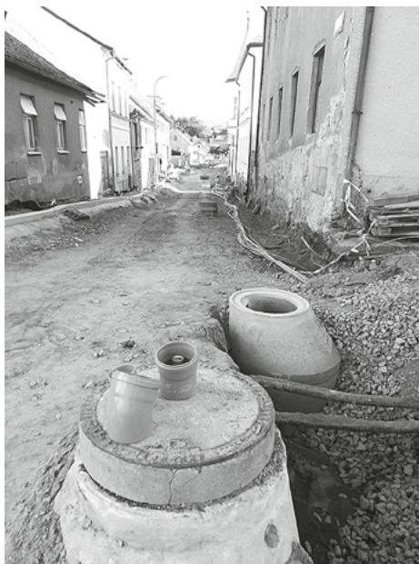
Začíná se opravovat Jetřichovická ulice
