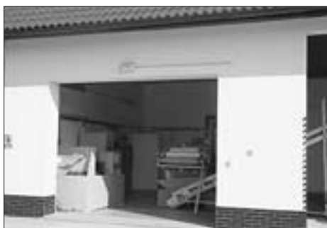
Zařízení na lisování kalů na ČOV v Sedlci
