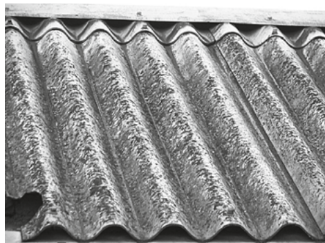
Staré eternitové krytiny ještě dnes nalezneme na řadě střech rodinných domů, stodol, chat a chalup
