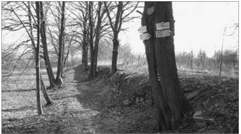
Okolí Ježovky po provedených technických úpravách
