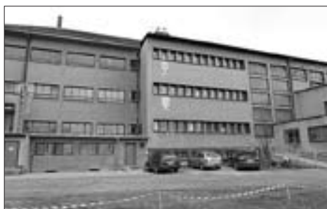
Škola zateplení nutně potřebuje, úniky jsou velké
