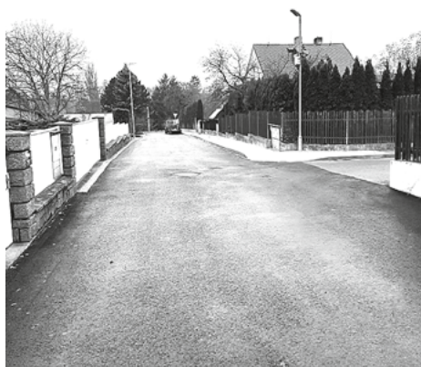
Nový asfaltový povrch v ulici Generála Svobody
