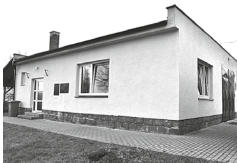
V Divišovicích dojde k vybudování zpevněné plochy a pergoly u hasičské zbrojnice
