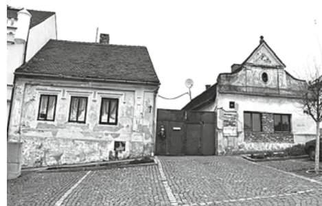
V plánu je i projekt na rekonstrukci domů čp. 70 a 138 na náměstí v Práči (vedle staré radnice)
