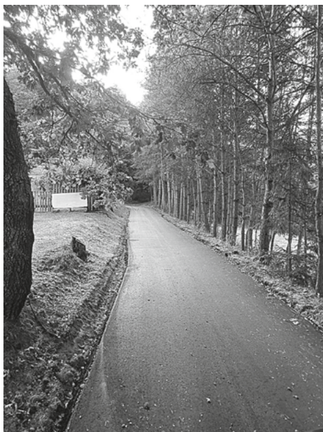
Opravený povrch silnice v Nových Dvorech
