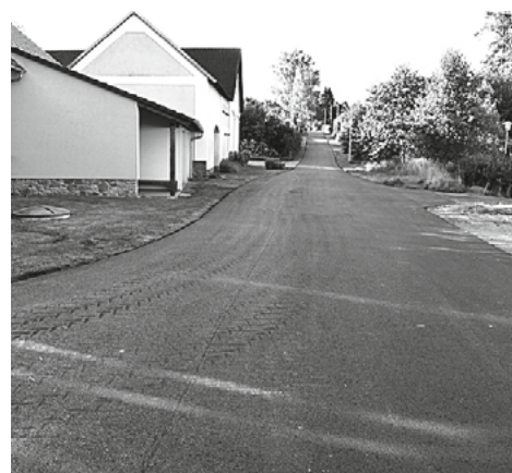
Nový asfaltový povrch na návsi v Choteticích
