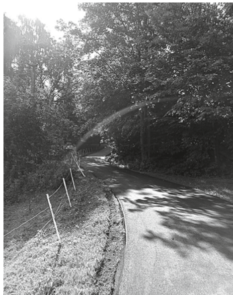
Nový asfalt v úseku Veletín–„Buckovna“
