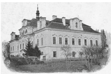
Zámek Nové Mitrovce na dobové pohlednici
