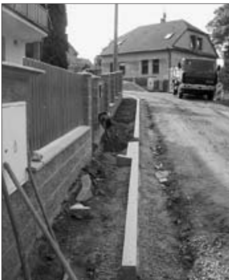
V rámci rekonstrukce jsou instalovány také nové obrubníky a pokládáno nové vedení veřejného osvětlení a městského rozhlasu
