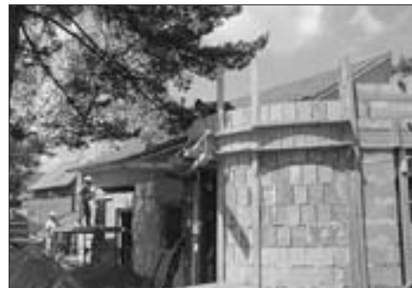
Práce na přístavbě výtvarného ateliéru ZUŠ...
