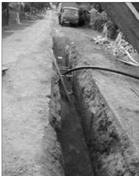
Součástí rekonstrukce je i položení nového vodovodního řadu a vodovodních přípojek
