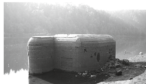
Řopík – pozůstatek opevnění – vystupující z říčního dna
