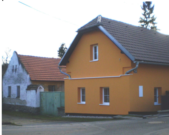
NEVHODNÁ POLOHA ŘÍMSY VE ŠTÍTU PO ZATEPLENÍ NEVHODNÉ TVAROVÁNÍ PŘI ZATEPLENÍ FASÁDY
