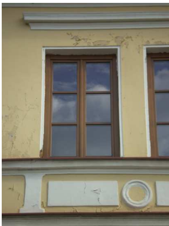
ZDAŘILÁ VÝMĚNA OKEN
