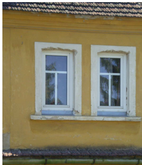
RÁMY NEZAPUŠTĚNÉ DO OSTĚNÍ A ÚZKÉ PŘÍČLE
