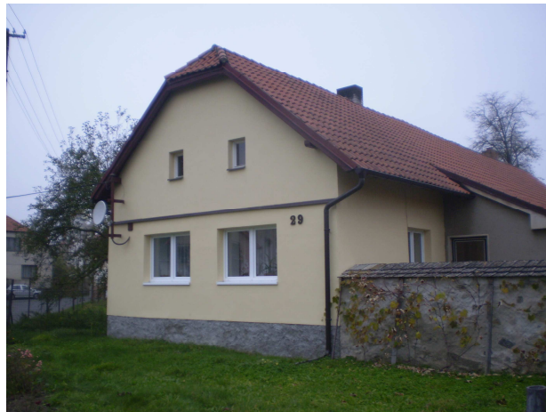
NEVHODNÁ POLOHA ŘÍMSY VE ŠTÍTU PO ZATEPLENÍ NEVHODNÉ TVAROVÁNÍ PŘI ZATEPLENÍ FASÁDY
