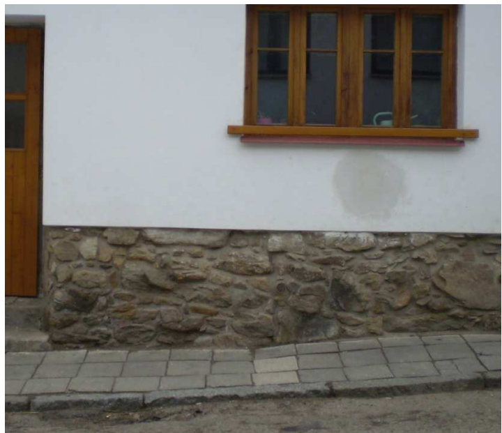
ODHALENÍ A VYSPÁROVÁNÍ KAMENNÉHO ZDIVA
