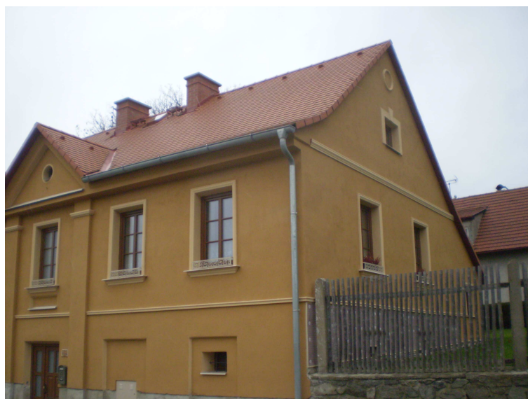
Č.P.110 UL. BRATŘÍ ČECHŮ
