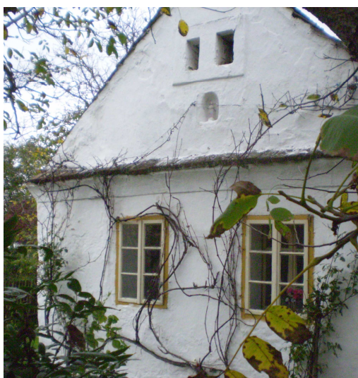
TRADIČNÍ ZDĚNÝ ŠTÍT CIHLOVÉ ČLENĚNÍ ŠTÍTU STODOLY
