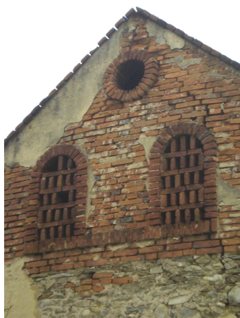
TRADIČNÍ ZDĚNÝ ŠTÍT CIHLOVÉ ČLENĚNÍ ŠTÍTU STODOLY
