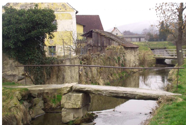
KAMENNÁ LÁVKA PŘES SEDLECKÝ POTOK
