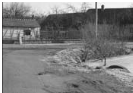
Nového povrchu i svodidel podél Prčického potoka se dočkají v Blatecké ulici
