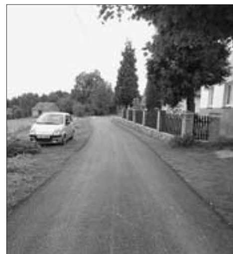
Nový asfaltový povrch v Dolním Matějově
