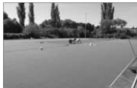
a při pokládání umělého povrchu na hřišti
