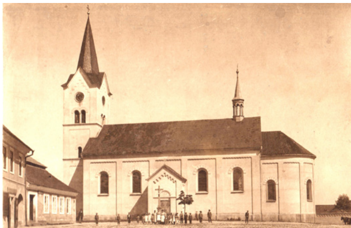
Sedlecký kostel před přestavbou kolem roku 1895 a po ní, kolem roku 1900
