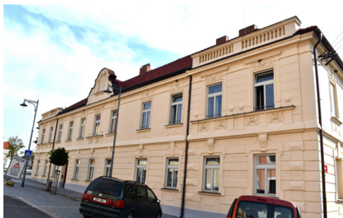
Ozdobná balustráda a římsa na bývalém okresním domě v Sedlci
