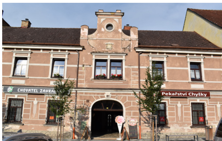
Před požárem bývala sedlecká radnice (rychta) v sousední budově
