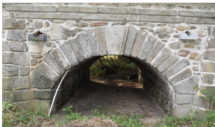
Kamenná klenba z klenáků
