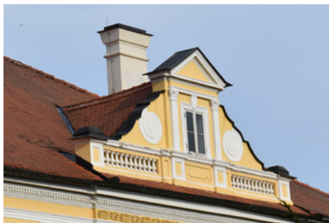
Ozdobná balustráda na střeše přičekého zámku
